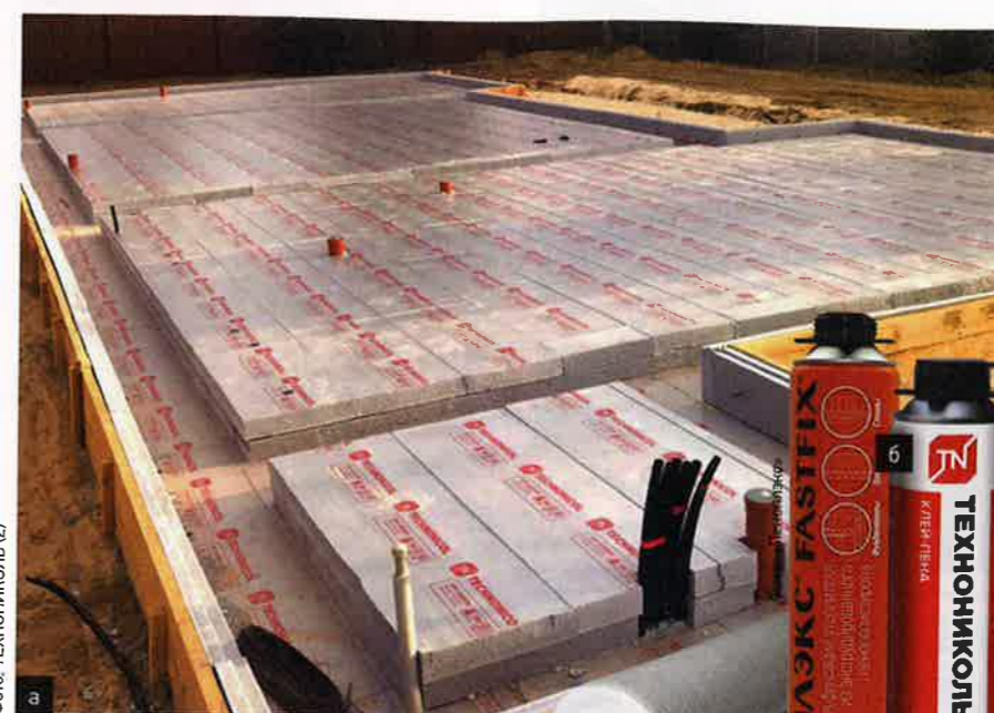
↑→ В процессе монтажа шведской плиты (а) стыки утеплителя заделывают клей-пенной (б). При устройстве подушки слои разделяют геотекстилем (в), что способствует более равномерному распределению нагрузки на основание
