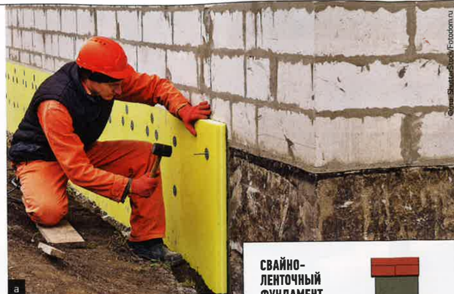
↑↓ Утепление цоколя плитами экструзионного пенополистирола (а) и «заякоривание» ленты с помощью буровых свай (б) — эффективные средства борьбы с силами морозного пучения
