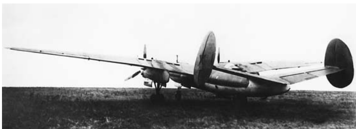
Первый вариант дальнего высотного бомбардировщика ДВБ-102 с моторами М-120 (вид сзади)
