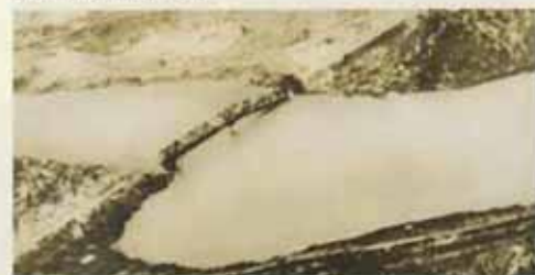
Мост в Северном Вьетнаме, разрушенный прямым попаданием УАБ
